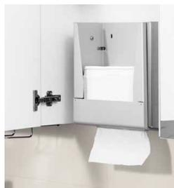
Für die Nachbefüllung muss der Spiegel aufklappbar oder der Schrank zu öffnen sein.
