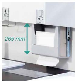
Papierhandtuchspender mit Hilfe der Führungsschiene zum Nachfüllen herabgezogen.
